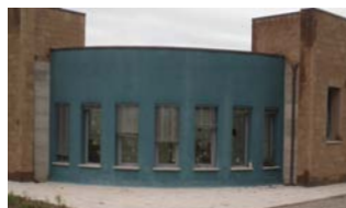
la nuova struttura inaugurata nel 2009
